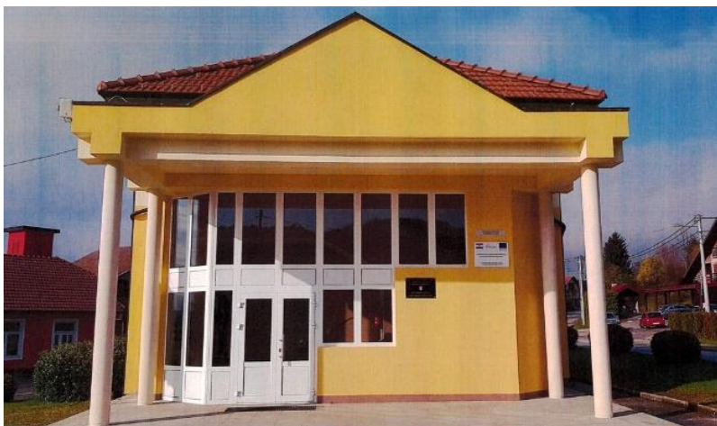
Slika 5.: Zgrada Općine Dubravica
