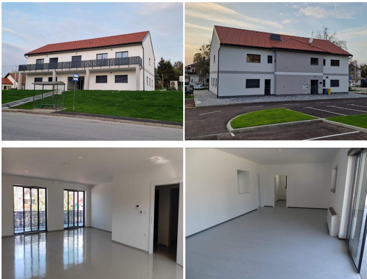
Slika 11. Novoizgrađena ambulanta u općini Dubrava
