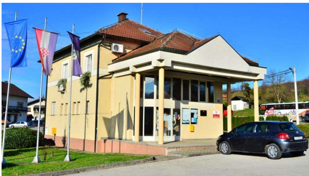
Slika 5.: Zgrada Općine Dubrava
